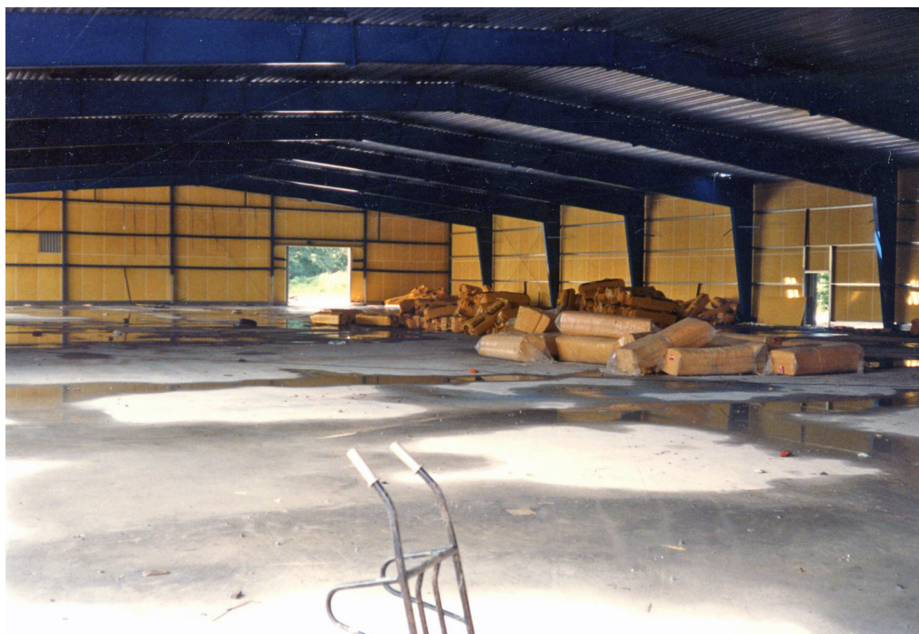
Ombyggnad av Kirsebergs ishall
